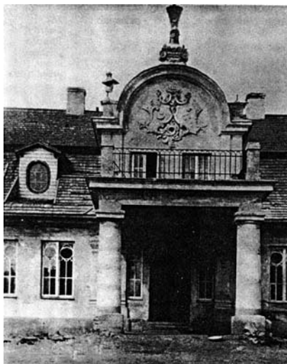
Portyk dworu po przebudowie
