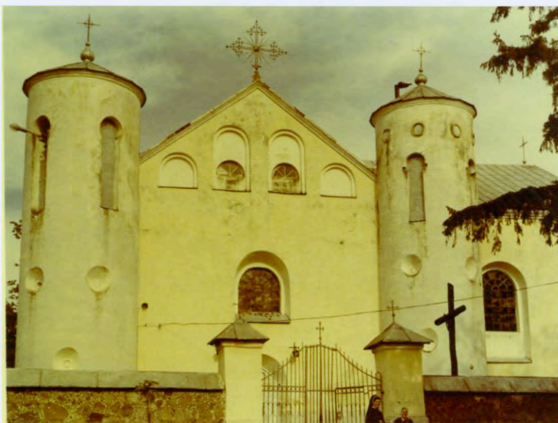
Kościół św. Jana Chrzciciela w Komajach. Obronny, o charakterze gotyckim, zbudowany w latach 1603-1606, przebudowany po pożarze w połowie XVII w. W 1778 r. dobudowano kaplicę z kryptą. Świątynia zamknięta po 1945 r., została zwrócona wiernym w 1985 r.
