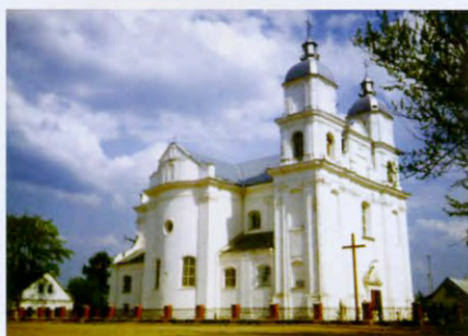
Kościół pod wezwaniem Trójcy Świętej w Dunilowiczach. Wybudowany w latach 1769-73 przez dominikanów, których sprowadziła tutaj Elżbieta z Isajkowskich Białozorowa. Po kasacie klasztoru przez władze carskie w 1866 r. kościół zamieniony na cerkiew prawosławną. W 1919 r. powrócił do katolików, w 1948 r. odebrano go ponownie i użytkowano jako magazyn nawozów sztucznych, w 1989 r. zwrócony wiernym.
